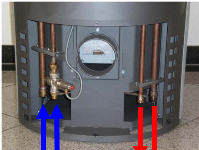
TAS-Eingang TAS-Ausgang Heizungs-rücklauf Heizungs-vorlauf
