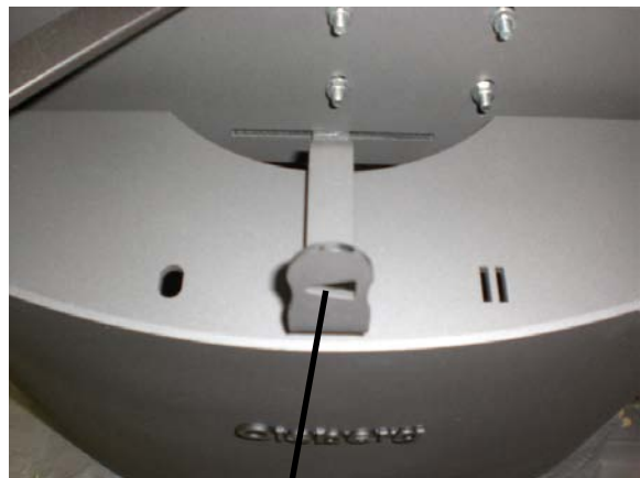
Regelhendel voor de verbrandingsluchttoevoer
