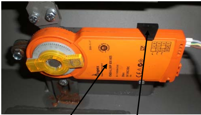
Moteur de commande Agrafe de maintien du moteur
